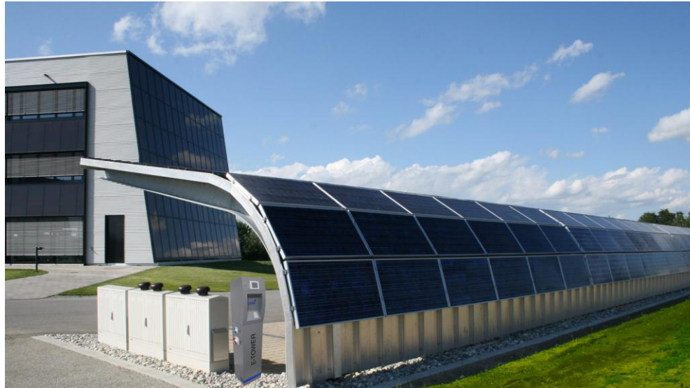
Abri photovoltaïque avec bornes de recharge
