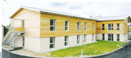
Pour l'établissement de Montanay, OVE et MV Groupe ont travaillé à la construction et au fonctionnement au meilleur coût.
