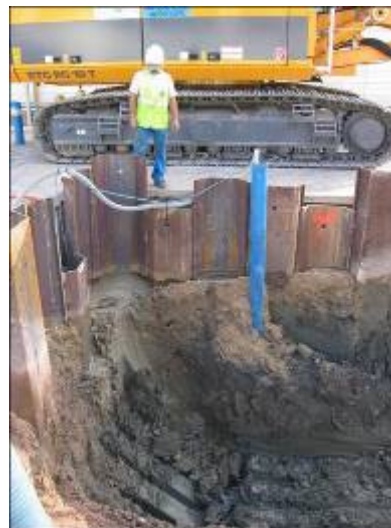
Pompage – Rabattement des eaux souterraines à l'intérieur du blindage
